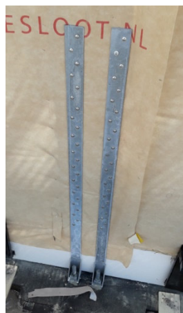
Figuur 3-2; stabiliteits verankering
