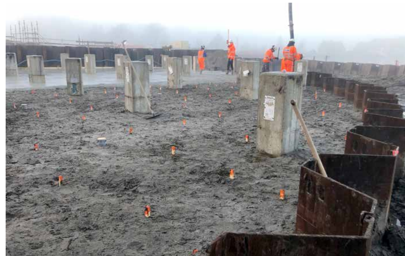
Er is ontzettend weinig ruimte op de bouwplaats, gelegen op de rand van de dam en zelfs deels in het water.
